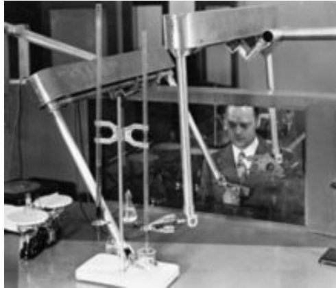
Rysunek 1.1 Mechaniczny manipulator slave-master
